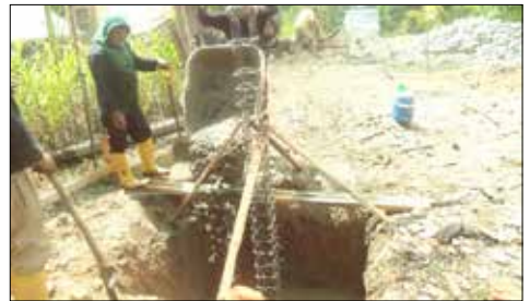
Löcher für Stützpfeiler gegraben und einbetoniert
