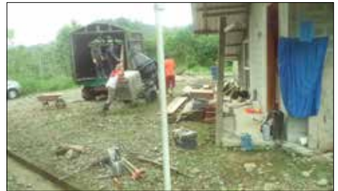
Das Baumaterial wird gebracht
