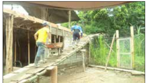
Beton fürs Obergeschoss in Handarbeit transportiert
